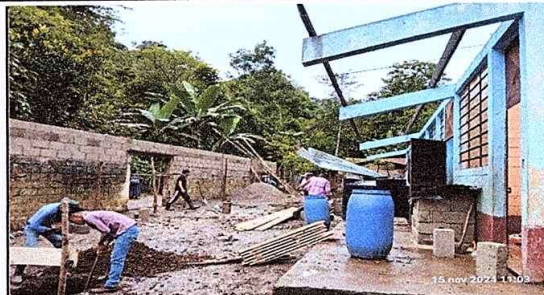
Foto 2: Ampliación cubierta y estructura de techo en el corredor.
