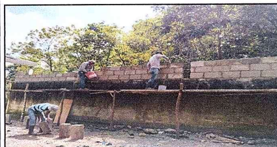
Foto 5: Levantamiento de 4 hileras de block en muro perimetral
