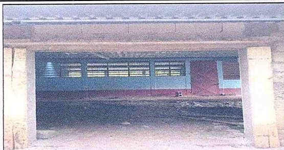
Foto 1: Colocación de portón en entrada principal del centro educativo.
