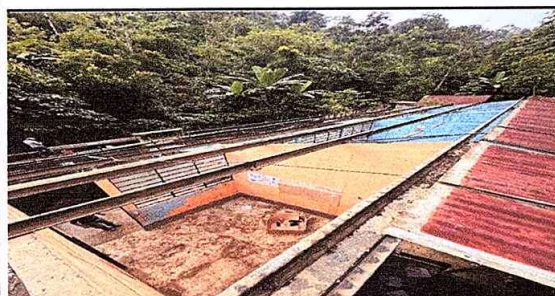
Foto 3: Mantenimiento de estructura de techo lijado y pintado. Instalación de cubierta de lámina.
